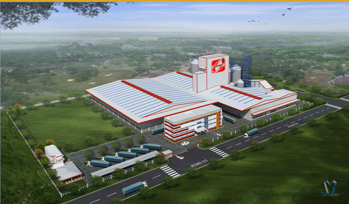
NHÀ MÁY CÔNG TY TNHH EMIVEST FEEDMILL VIỆT NAM EMIVEST FEEDMILL VIETNAM CO. LTD
